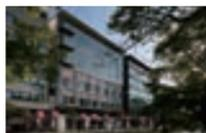
高知城の前に建つ中間層免震を採用した4~6階建て木造の庁舎。木造耐火構造の被覆型による告示と大臣認定、CLT耐震壁、木材現し筋交いなど、木造耐火建築物における意匠・構造・防耐火のデザインと技術が融合されている。2018年日本免震構造協会賞(作品賞)を受賞。
