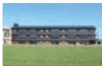
2015年の改正建築基準法を受けて、イ準耐火建築物(1時間)で設計可能となった、日本発のオール木造の3階建て小学校。実大火災実験の結果を実設計に活かした、安全な木造学校が実現している。この後の木造3階建て学校のプロトタイプとなり得る取り組み。2019年竣工。
